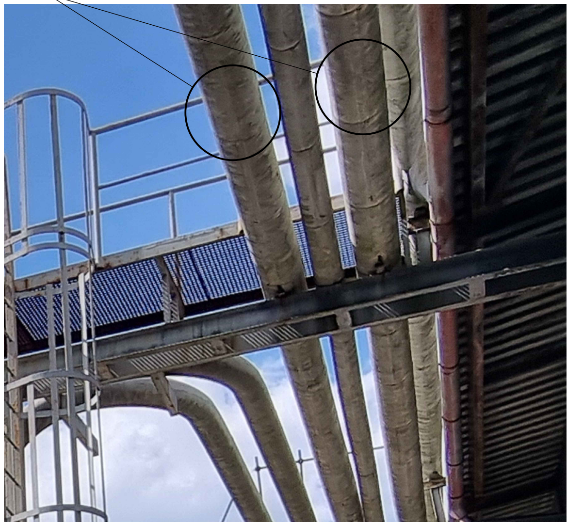
Zavěšení nosníků pro podepření kanelových žlabů na stávající potrubí po max. 3,0m
